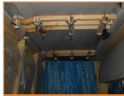
接合部型枠設置
