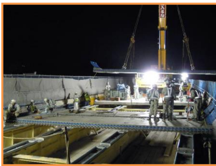
SLJスラブ架設
