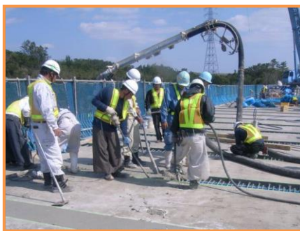
コンクリート打設
