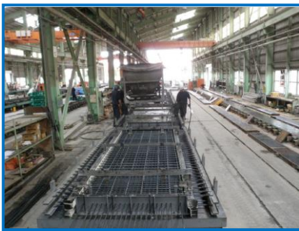
コンクリート打設
